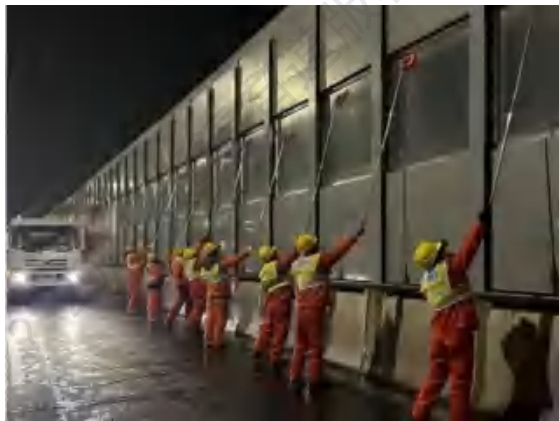
快速路隔音板（高压水枪）
